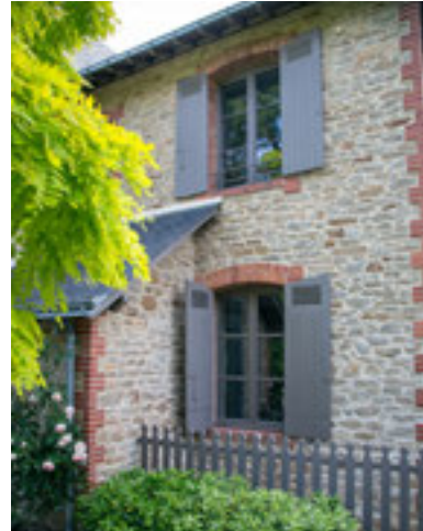
Finition des volets réalisée par le client
